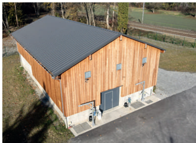
La station d'épuration
